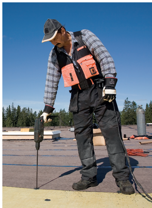
Montaż z użyciem łączników Vilpe na dachu płaskim.
